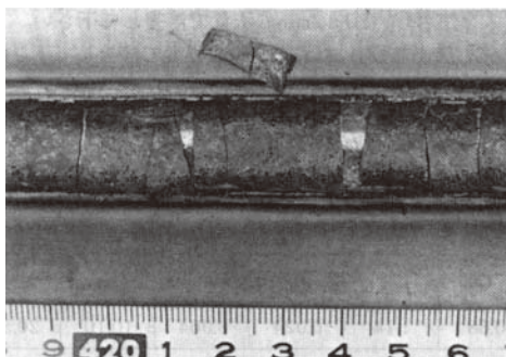
突合せ溶接ビード外観（スラグ被包状態）
